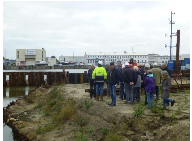
auf der Baustelle Bereich alter Fähranleger
