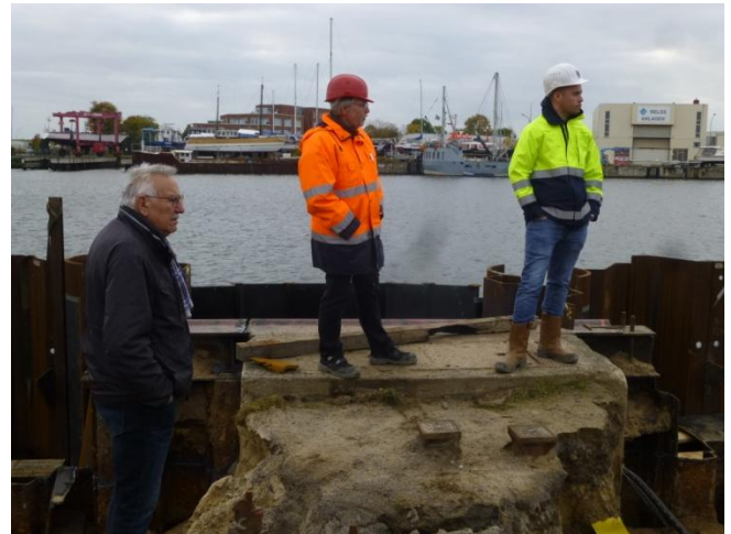
auf der Baustelle alter Düker – im Spundwandbereich
