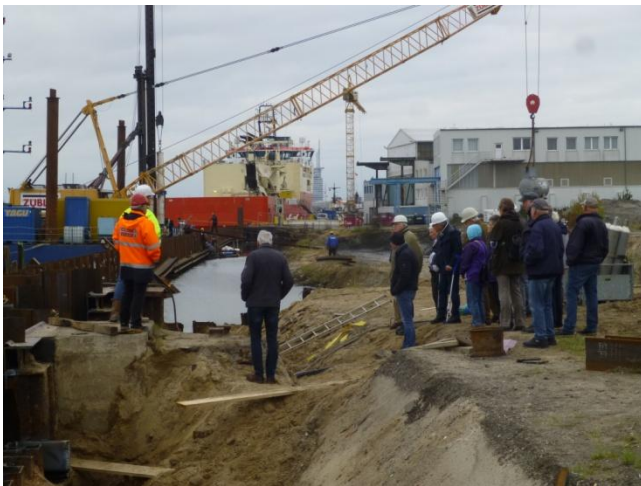
auf der Baustelle Blick in Baugrube – Ankerstrecke
